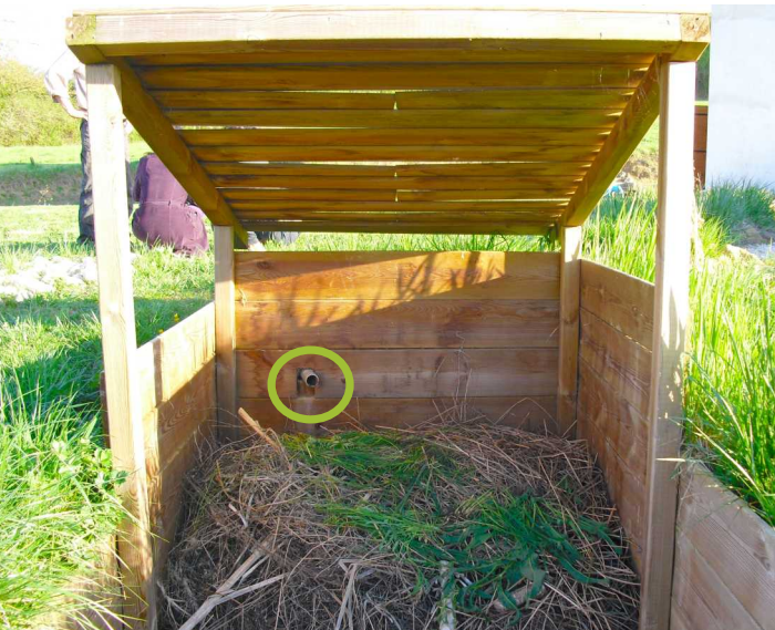
Exemple de tractament conjunt de la matèria provinent d'un vàter amb separació a l'origen. L'orina es canalitza directament a la pila de compost
