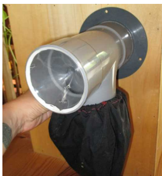
Muntatge d'una trampa per a mosques, extreta de la guia d'instal·lació d'Ecodomeo
