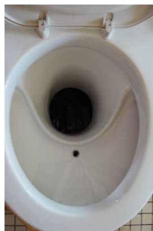
(a dalt) Vàters amb cinta transportadora amb separació per gravetat.
