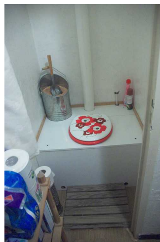
(a l'esquerra) Vàter sec sense separació per a una família amb un cubell de 80 l
